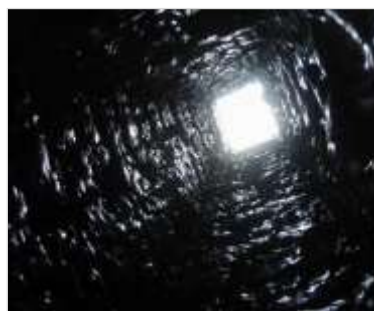
Slika 16; Katranske obloge v dimniku kot posledica zelo slabega zgorevanja zaradi vlažnih drv in nepravilnega kurjenja
