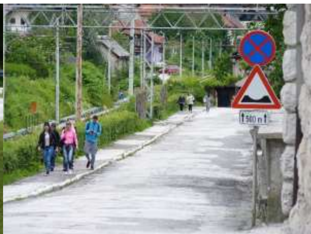
Slika 18: Površina za pešce je, enako kot cesta, v slabem stanju in ni primerna za gibalno ovirane in slepe
