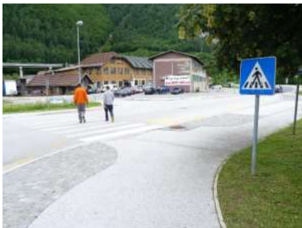
Slika 17: Urejena površina in prehod za pešce, tudi gibalno ovirane, ne pa za slepe
