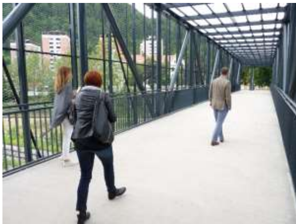
Slika 15: Urejen pokrit nadhod čez cesto in železnico, vendar dvigalo za invalide ob ogledu ni delovalo
