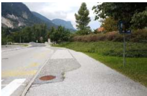
Slika 52: Primer neurejenega avtobusnega postajališča Kolpern, brez nadstrešnice in z zaraščenim prometnim znakom (Vir: PNZ d.o.o.)
