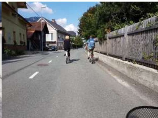
Slika 29: Ulica Heroja Verdnika sedaj deluje kot mešana prometna površina in potrebuje učinkovito omejevanje hitrosti ali ločene površine za kolesarje in pešce
