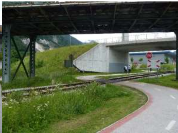
Slika 25: Urejena mešana prometna površina in (nezavarovan) prehod čez železniško progo za kolesarje in pešce
