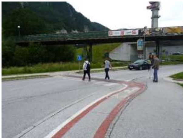
Slika 24: Urejena prometna površina in prehod čez cesto za kolesarje in pešce
