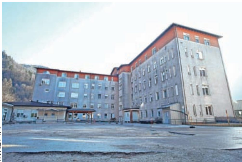
Parkirišče na zgornjem dvorišču je že zaprto, na njem bodo postaviličasne bivalne zabojnike, v katerih bodo uredili osem bolniških sob in spremljajoče prostore.
