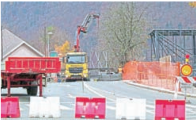
Zaradi obnove železniškega nadvoza je cesta med TVD Partizan in Gimnazijo Jesenice zaprta. / FOTO: JANKO RABIČ
