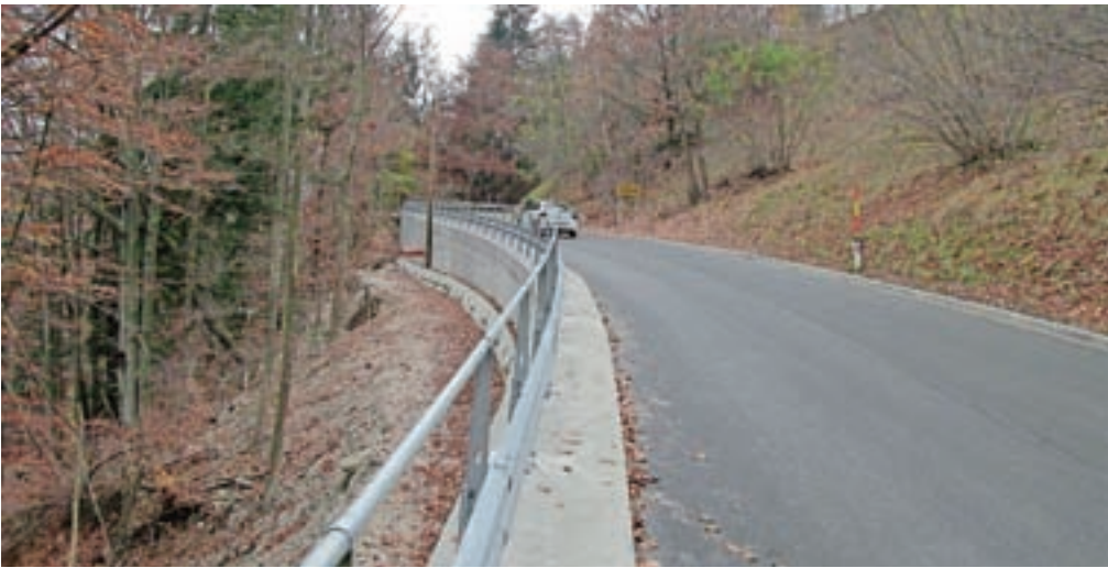
Cesta pod Prihodi je obnovljena.
