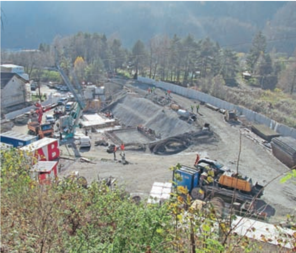
Sredi Hrušice je veliko gradbišče. / FOTO: JANKO RABIČ
