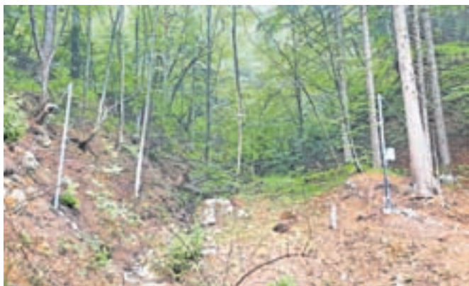
Spremljanje zemeljskih plazov / FOTO: ARHIV OBČINE JESENICE
