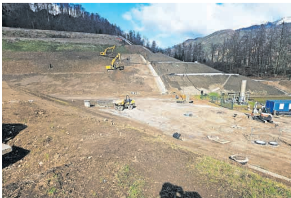
Gradbena dela na deponiji Mala Mežakla / FOTO: ARHIV OBČINE JESENICE
