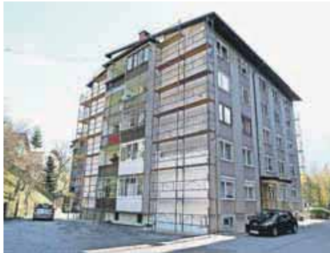
Vrsta večstanovanjskih objektov na Jesenicah je v zadnjem času dobila novo fasado z boljšo toplotno izolacijo.
