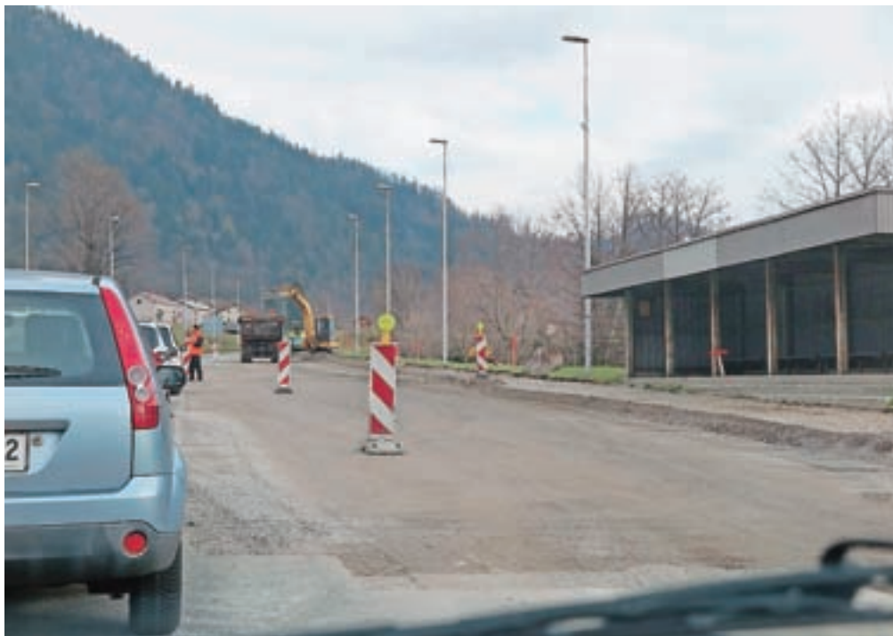
Zaključuje se tudi obnova odseka ceste od Turista do Petrola na Koroški Beli.
