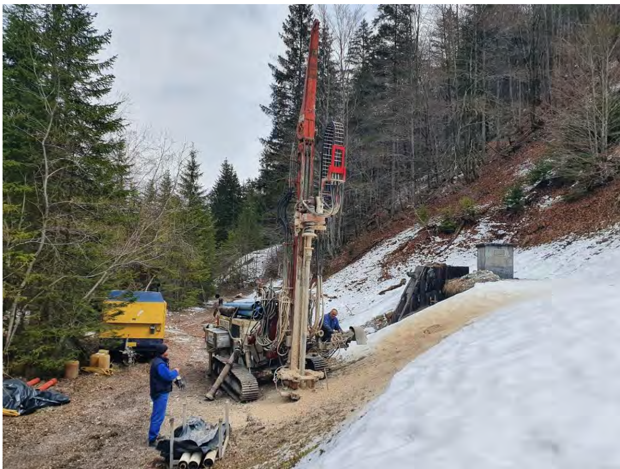
Slika 3: Izvedba vrtine PZP-2/21.
