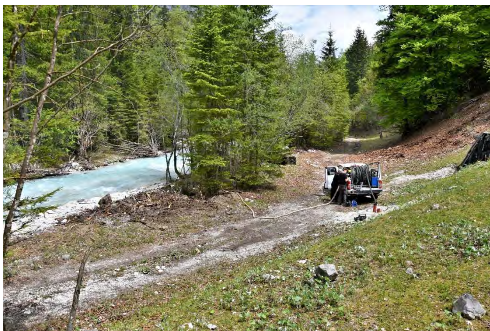
Slika 5: Potek črpanja na vrtini PZP-2/21.
