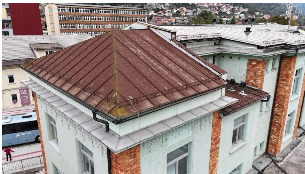
Slika 51: Streha iz zraka na JZ strani stavbe
