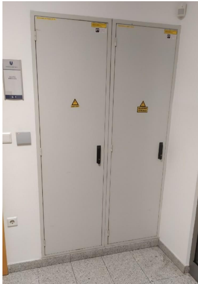
Slika 27: Glavna R-G in razdelilna R-K elektro omara
