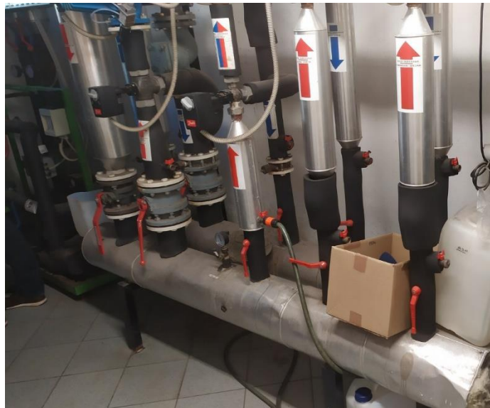
Slika 17: Povratki in dovodi ogrevalnih vej
