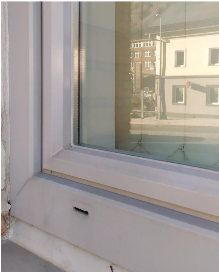
Slika 54: PVC okvirji z dvoslojno zasteklitvijo
