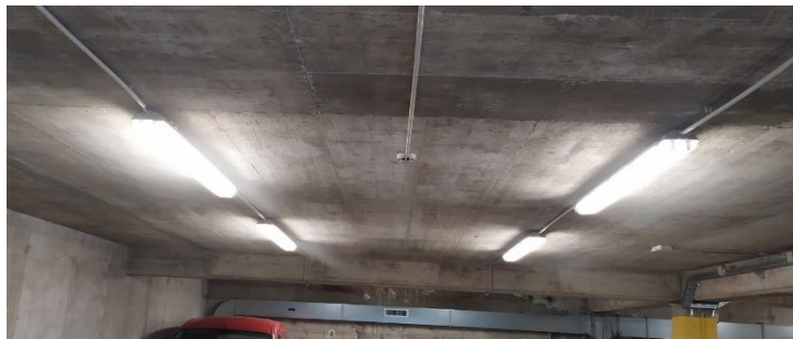
Slika 37: Fluorescentne sijalke tipa T8 v garaži
