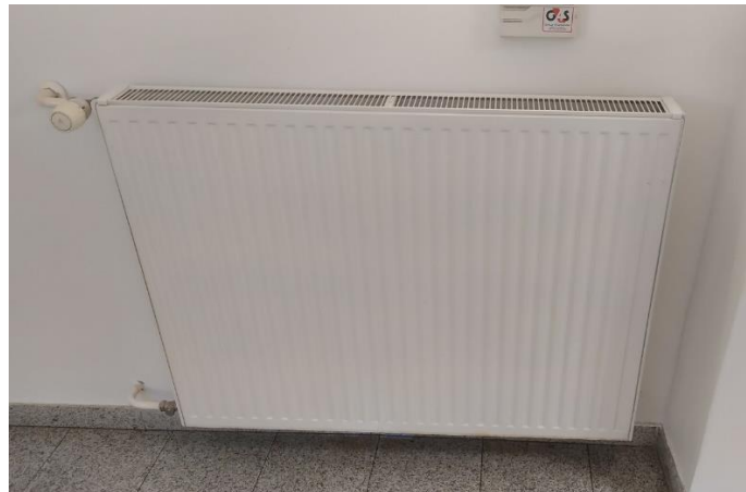
Slika 23: Radiator z ventilom s termostatsko glavo
