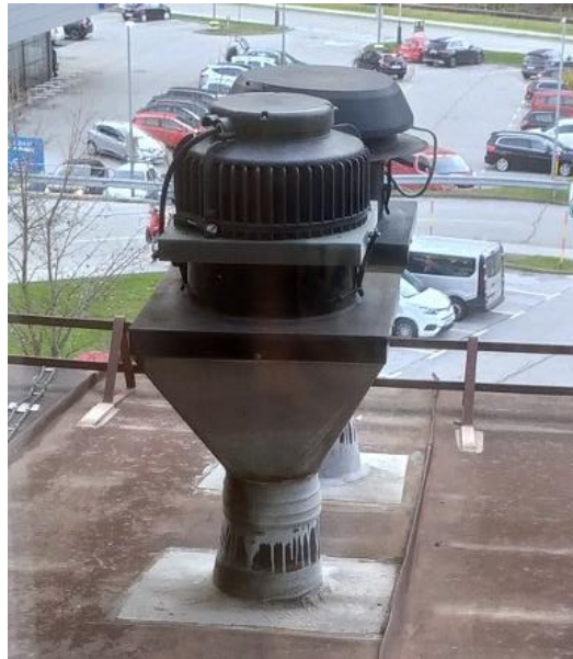
Slika 26: Lokalne mehanske prezračevalne naprave na strehi stavbe
