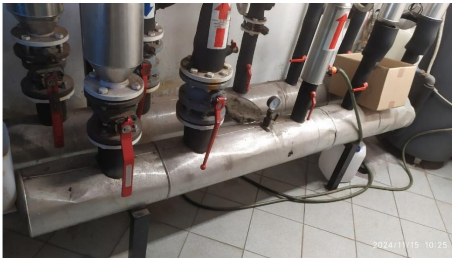
Slika 14: Sekundarni krog za daljinsko toploto
