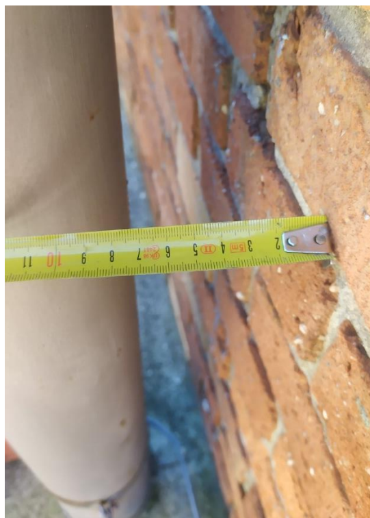
Slika 45: Razdalja med fasado in žlebom
