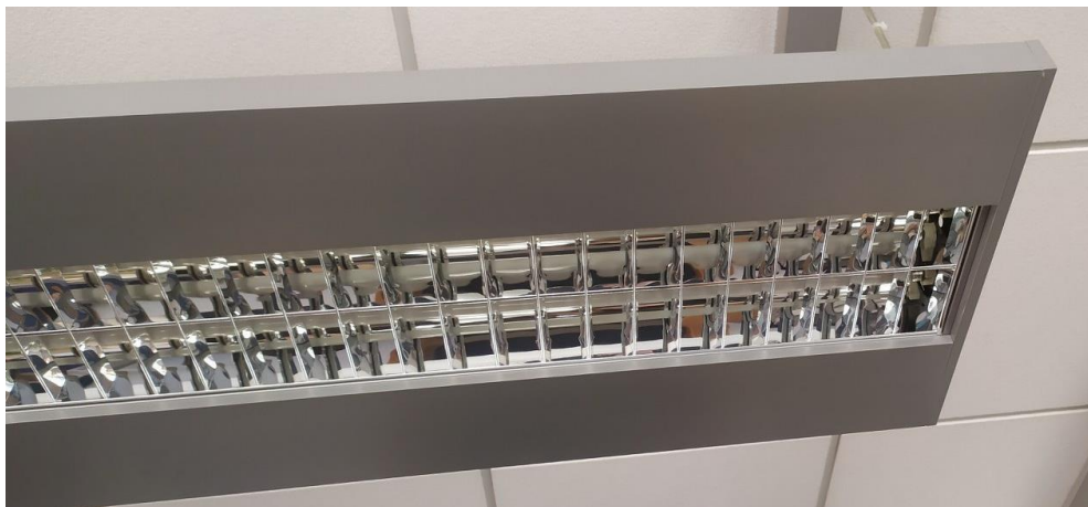
Slika 38: Fluorescentne sijalke tipa T5 36 W v vhodni avli
