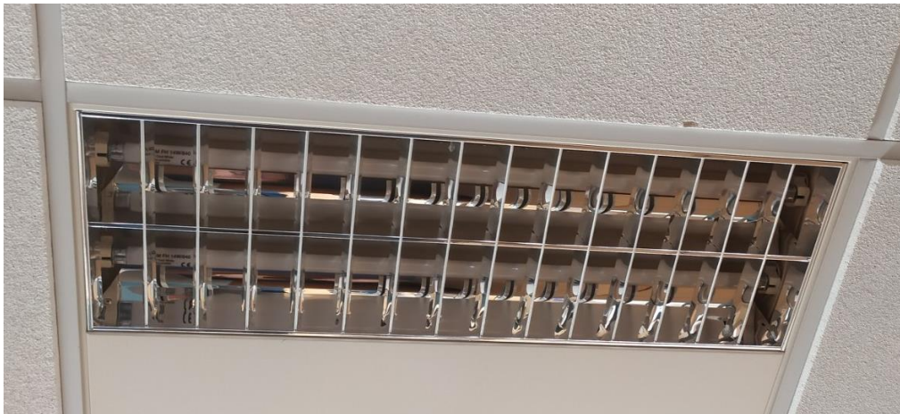
Slika 39: Fluorescentne sijalke tipa T5 14 W v pisarni
