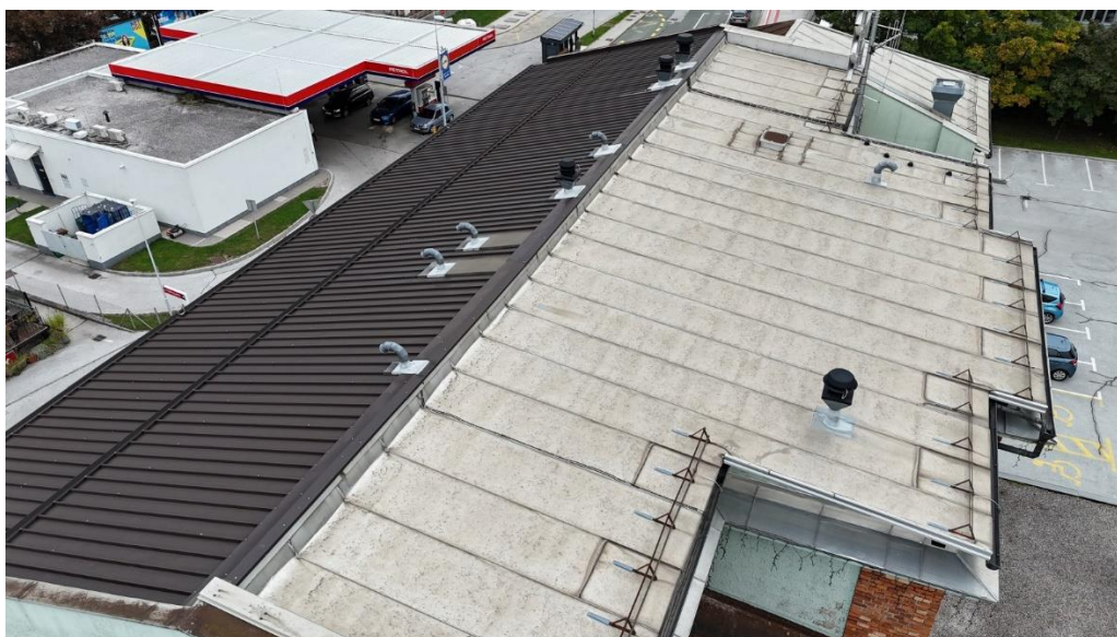
Slika 52: Streha na SV in JZ strani stavbe
