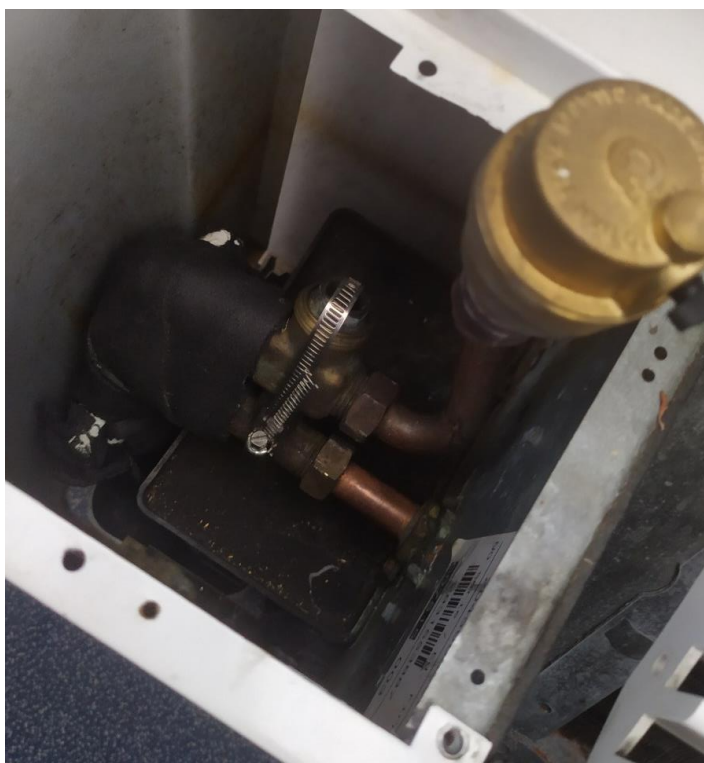
Slika 21: Odstranjena termostatska glava ventila na konvektorju
