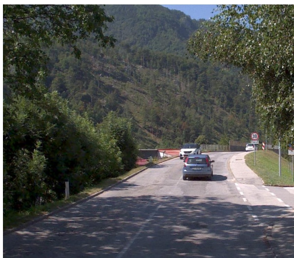
Odsek 152171 stac.: 0,120km
