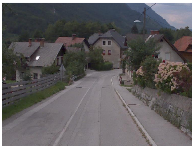
Odsek 152091 stac.: 1,008km
