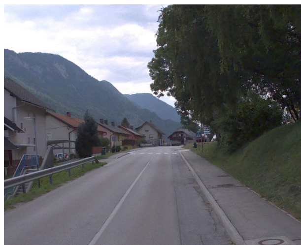
Odsek 152081 stac.: 337,10km
