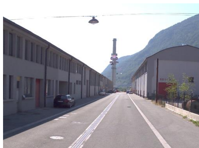
Odsek 152351 stac.: 0,240km
