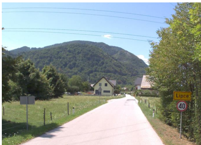
Odsek 152071 stac. 1,020km
