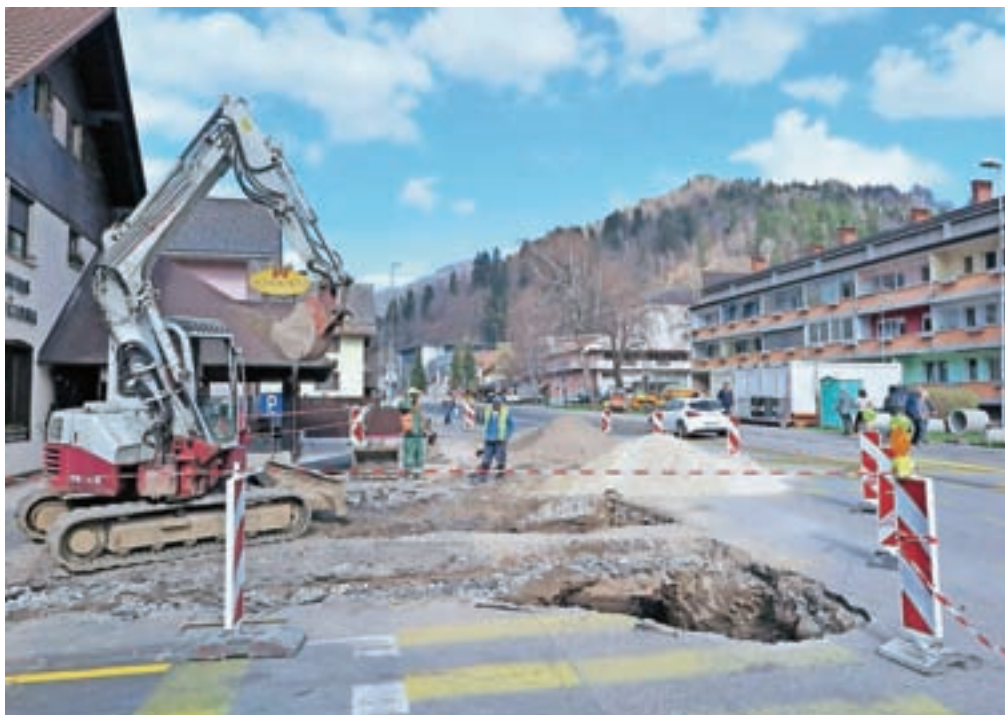
Obnova ceste pri Metuljčku in na mostu čez potok Jesenica se zdaj nadaljuje.
