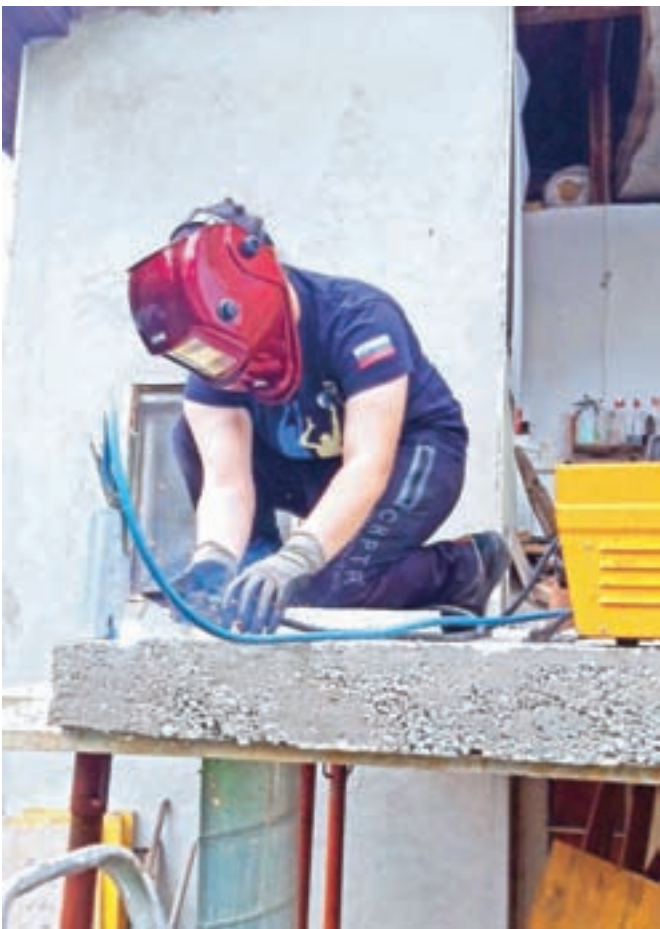
Pri varjenju konstrukcije za ograjo
