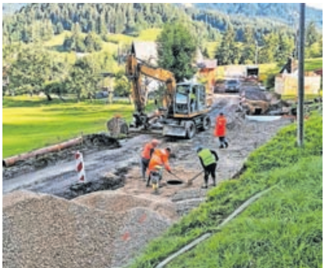
Obnova ceste na Prihodih / FOTO: ARHIV OBČINE JESENICE
