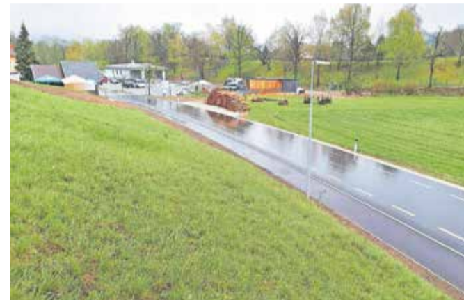
Obnovljenih je 120 metrov ceste proti pokopališču.
