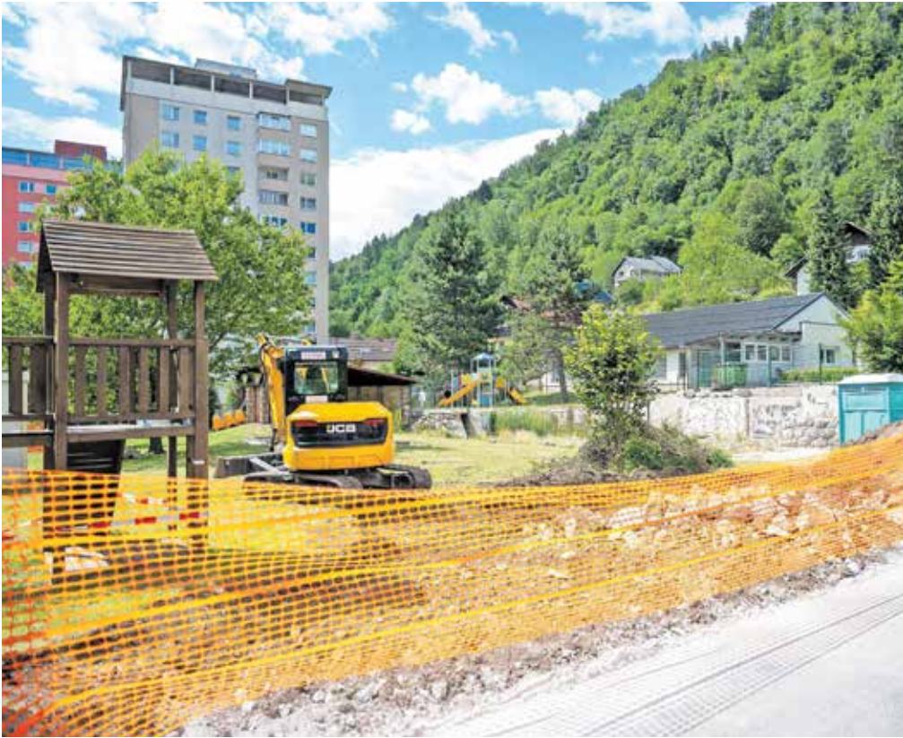
V kratkem bodo začeli graditi nov vrtec. / FOTO: NIK BERTONCEJ
