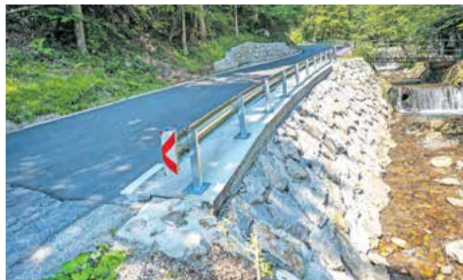
Zaključena poplavalna sanacija ceste v Javorniški Rovt
