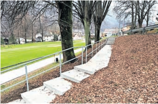
Novo stopnišče z ograjo / FOTO: ARHIV OBČINE JESENICE
