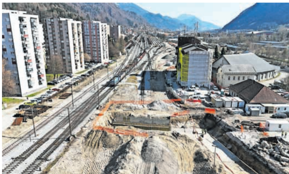
Območje ob železnici je veliko gradbišče. / FOTO: DIREKCIJA ZA INFRASTRUKTURO
