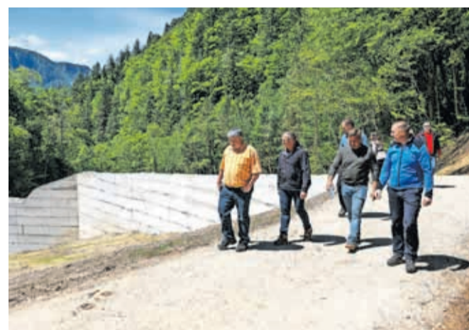
Armiranobetonska režasta pregrada nad vasjo
