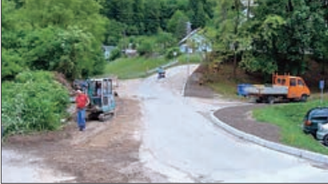
Obnova ceste na Hrušici.
