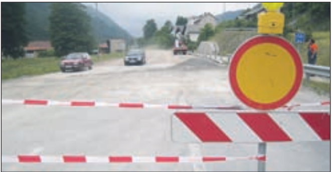
Promet na regionalni cesti od Jesenic mimo Hrušice proti Kranjski Gori je oviran.
