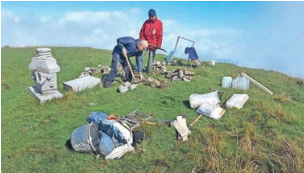
Gradbena dela na vrhu Golice
