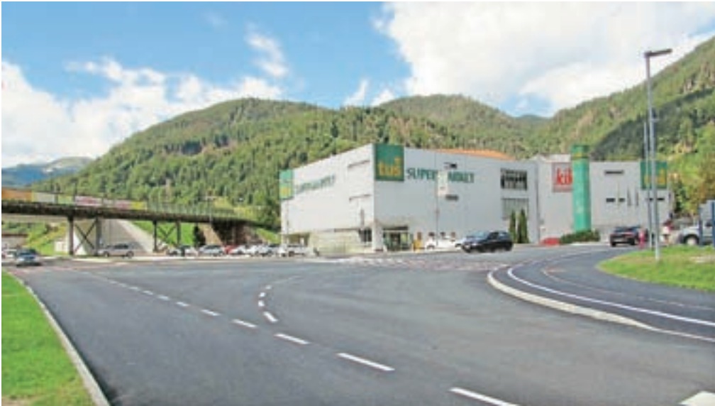
Obnovljeno križišče pri trgovini TUŠ
