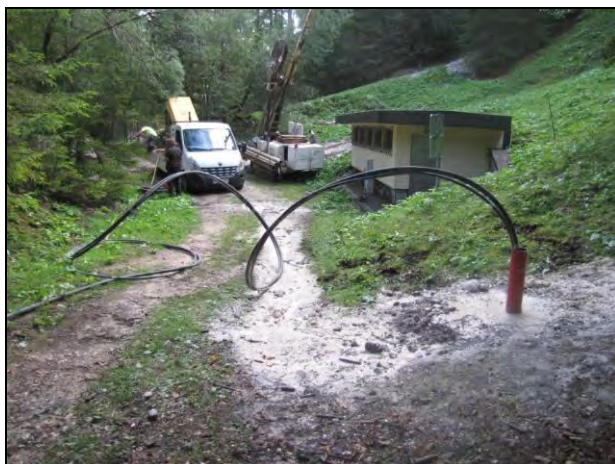
Slika 21, Slika 22: Oprema za izvedbo airlifta
