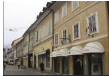
Objekt na Glavnem trgu 2 v Kranju – bodoča Kranjska hiša
