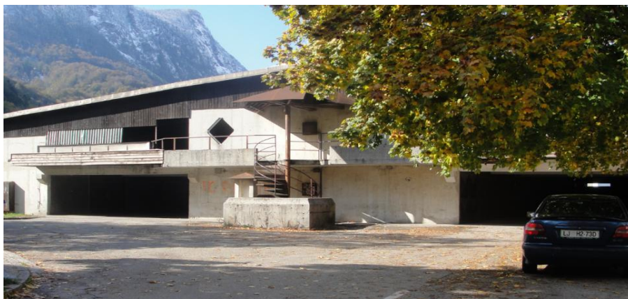
Večja garažna hiša starejšega tipa (premajhne dimenzije za parkiranje, ne vzdrževana infrastruktura, neosvetljenost...)
