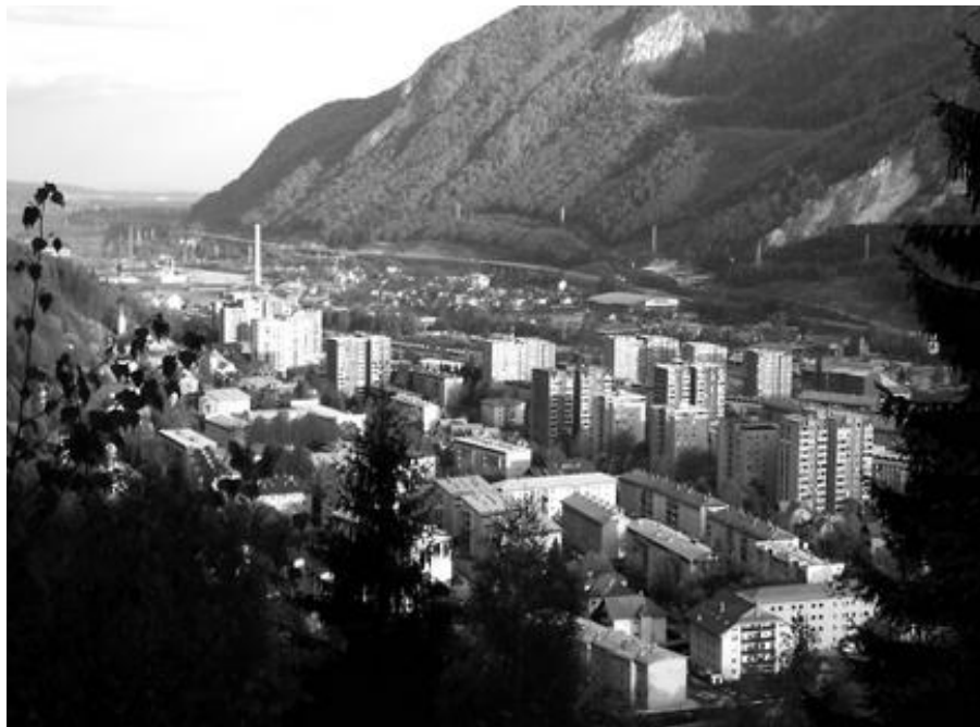
Gosta pozidava večstanovanjskih objektov na območju mesta Jesenice.
