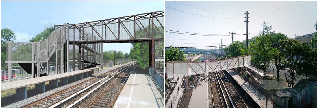
Slika 1-7: Nadhod nad železniško progo
