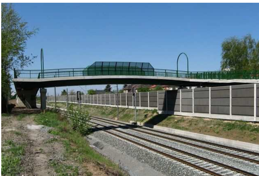
Slika 1-6: Nadhod za pešce in kolesarje v Plznu (Češka)
