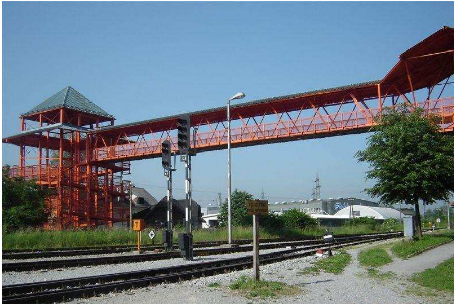
Slika 1-5: Nadhod za pešce in kolesarje Ljubljana Črnuče
