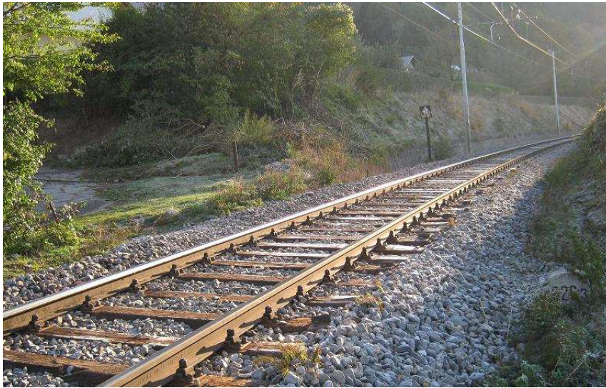
Slika 3-5: Ukinjeni nivojski prehod »Koroška Bela«
