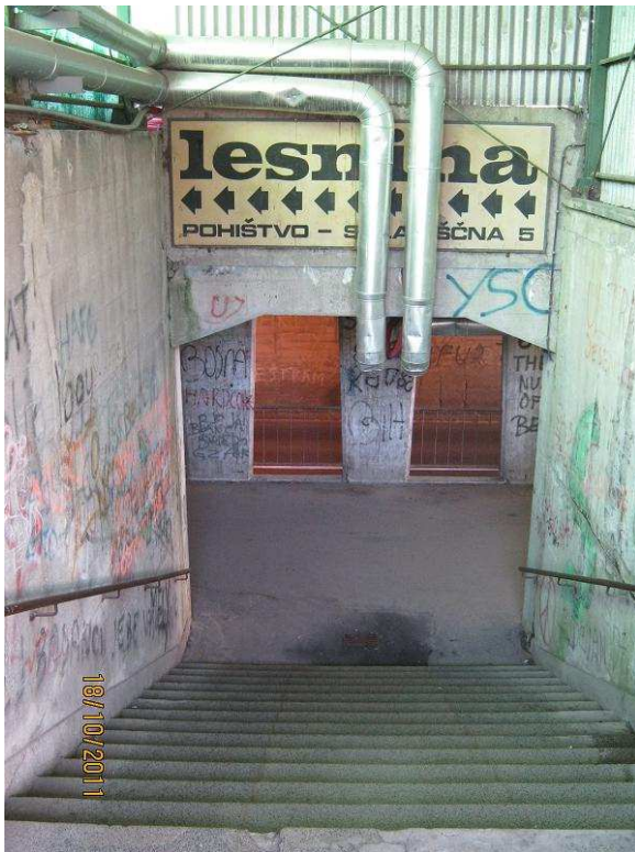
Slika 1-2: Pogled na vstop v podhod s ceste maršala Tita
