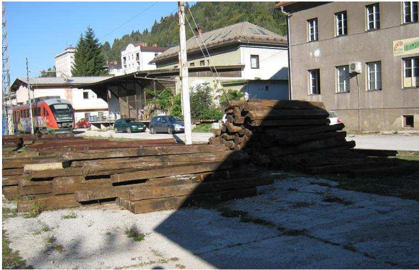
Slika 2-7: Pogled na železniške površine in objekte Cesta maršala Tita 5 in 7 (2.)
